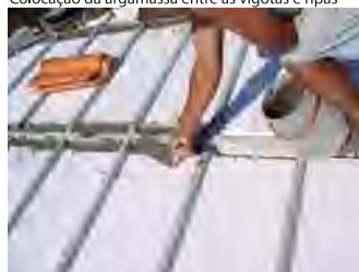
Colocación de la argamasa entre las viguetas y los rastreles
