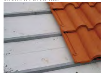
Cubierta con teja colocada
