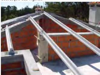
Colocación de las viguetas
