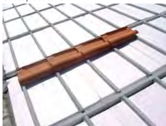
Colocación de la teja
