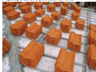
Preparación de la teja para asentamiento
