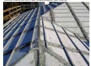
Cubierta tras la colocación de la teja
