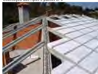
Colocación de los rastreles y placas EPS
